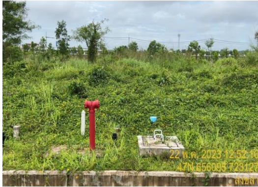
รูปที่ 19 อุปกรณ์ดับเพลิงในพื้นที่โครงการ ทุกๆ 200 เมตร
