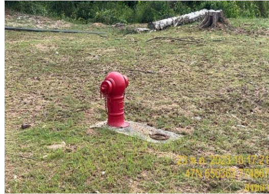
รูปที่ 19 อุปกรณ์ดับเพลิงในพื้นที่โครงการ ทุกๆ 200 เมตร
