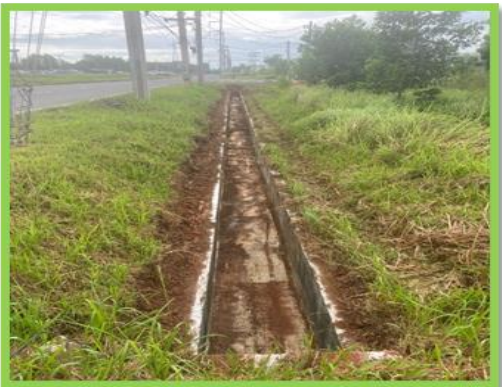
รูปที่ 2 การขุดลอกท่อระบายน้ำเสียและรางระบายน้ำฝนและบ่อฝัง
